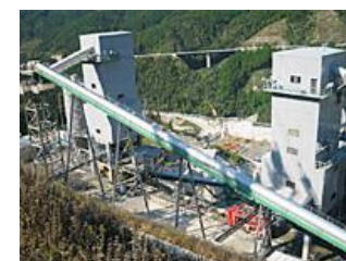
嘉瀬川ダムプロジェクト コンクリート製造設備
