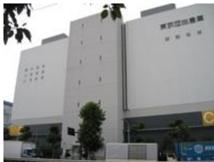
東京団地倉庫C棟
