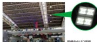
駅構内のLED照明
