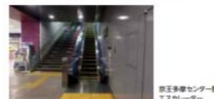
京王多摩センター駅 エスカレーター
