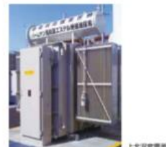
上北沢変電所
